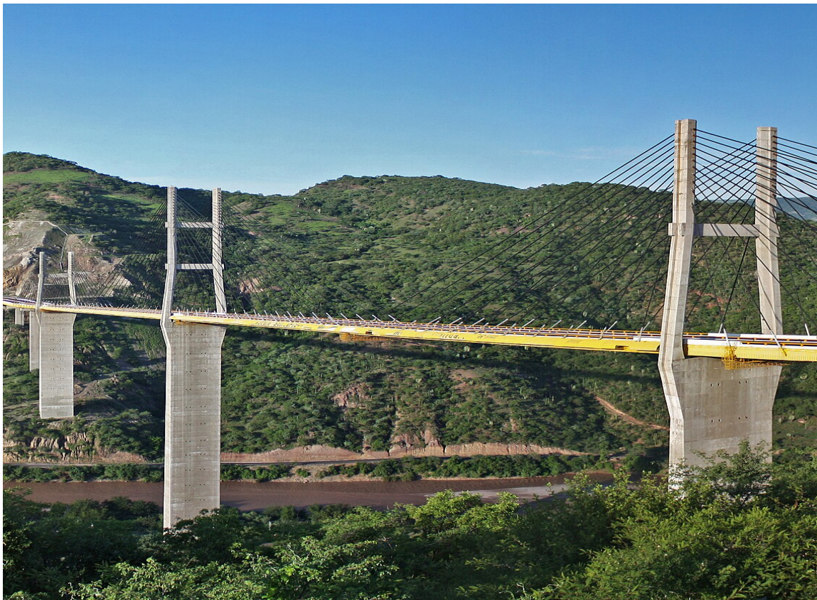
Puente Mezcala en la Carretera 95 en Guerrero, México.
